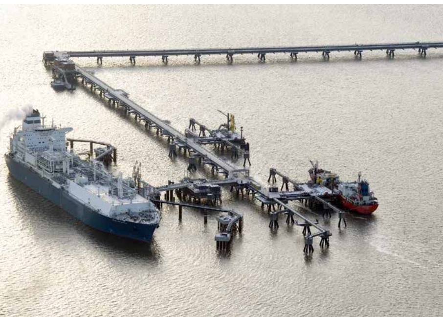
28 Abb.: LNG-Terminal Wilhelmshaven mit schwimmender FSRU [Quelle: NPorts_WScheer]
