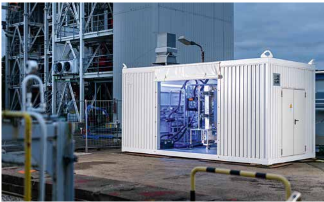
Abb. 1: Ambartec will die Eisenspeichertechnologie im Containerformat standardisieren [Quelle: Ambartec, Frank Grätz]
