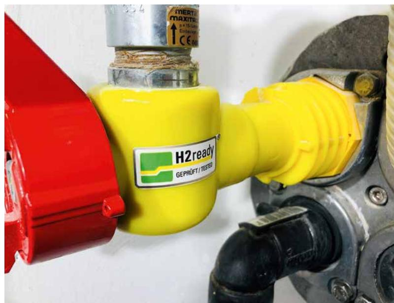
Abb. 2: Gashauseinführungen HSP von Schuck – für H<sub>2</sub>-Gas geeignet [Quelle: Schuck]
