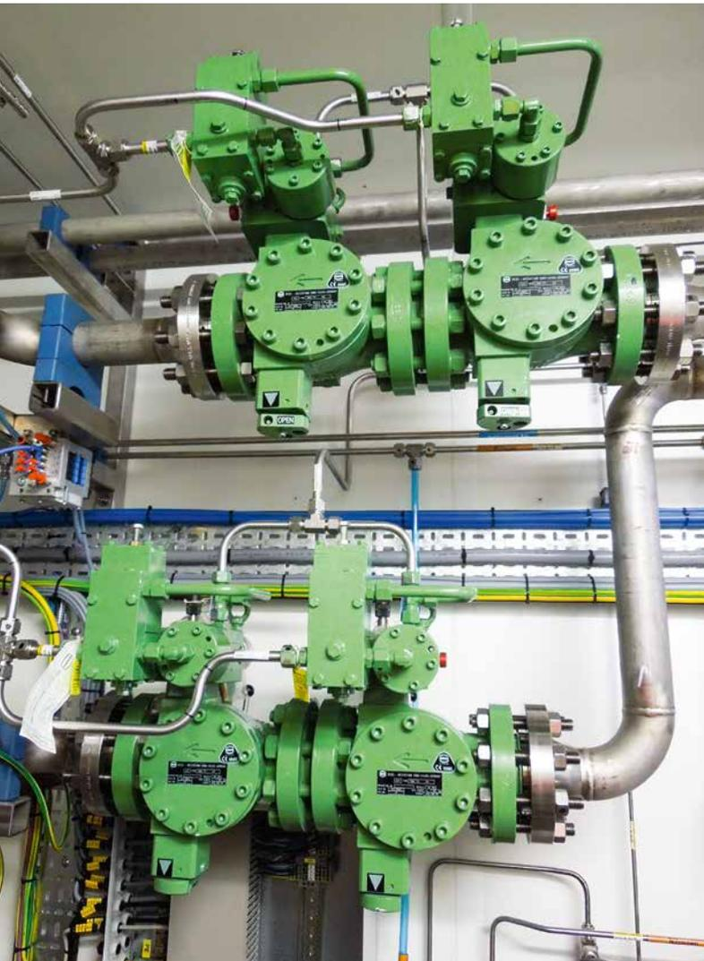
Abb. 2: Sicherheitsabsperrentile nach dem DVGW-Arbeitsblatt G 491 zur Unterbindung unzulässiger Drucküberschreitungen in der PtG-Anlage Falkenhagen [Quelle: Dr. Klaus Steiner]
