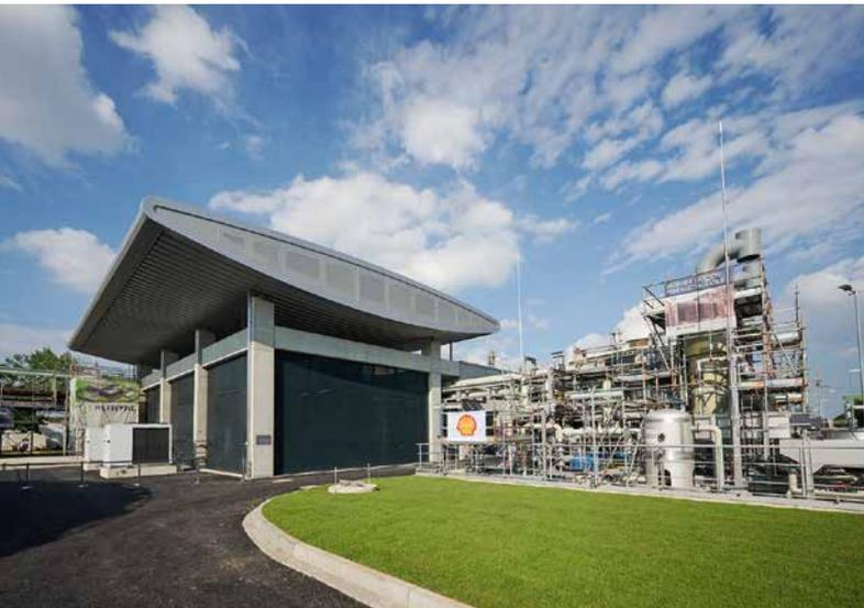
Abb. 2: Die PEM-Elektrolyseanlage REFHYNE I im Energy and Chemicals Park Rheinland [Quelle: Shell, REFHYNE-Projekt]
