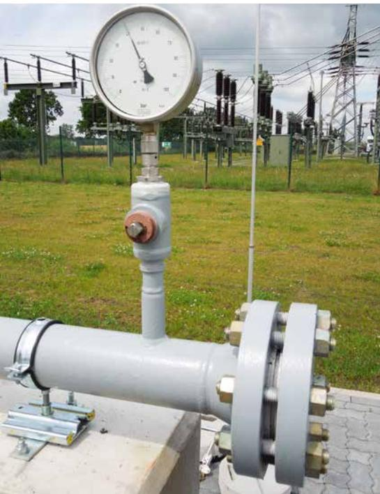
Abb. 1: Anschluss für eine mobile Molchschleuse an die H<sub>2</sub>-Pipeline in Falkenhagen [Quelle: Dr. Klaus Steiner]
